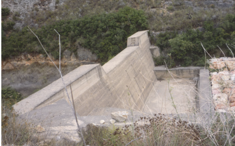
Fig. 4. The check dam.
